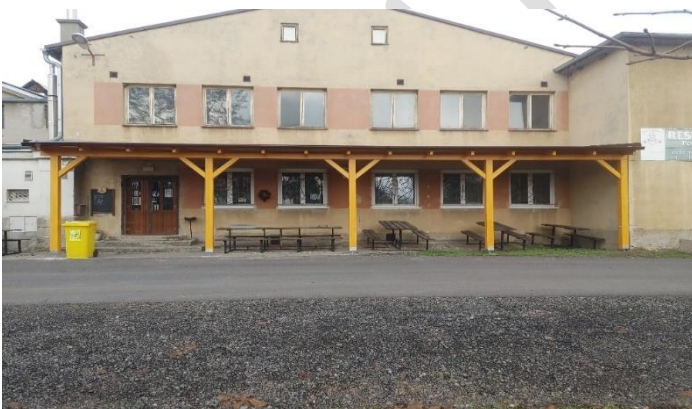
Nová pergola před místní restaurací – firma JES CZ s.r.o.
