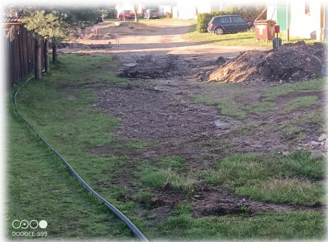
Opravy vodovodního řadu v Židovské čtvrti
