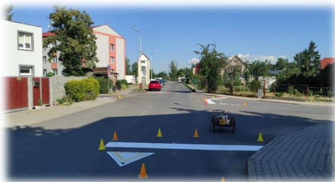
Instalace vodorovného dopravního značení v obci
