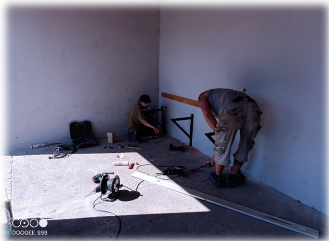
Čekárna byla za nemalé peníze opravena, instalována lavička, přesto si někteří občané neváží tohoto místa na návsi. Výkaly, zvratky, nepořádek je obcí uklízen každý den.
